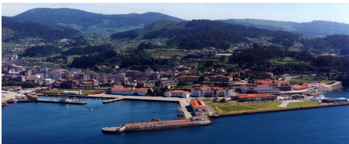
Ilustración 2. Vista panorámica de la ENM en la actualidad
